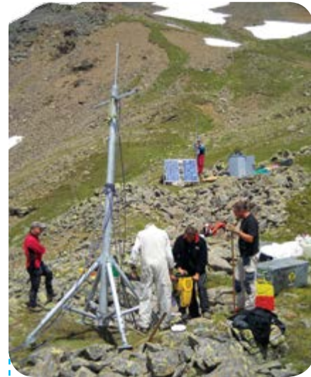
Tecnici di Trentino Network al lavoro per il progetto di connessione dei rifugi alpini
